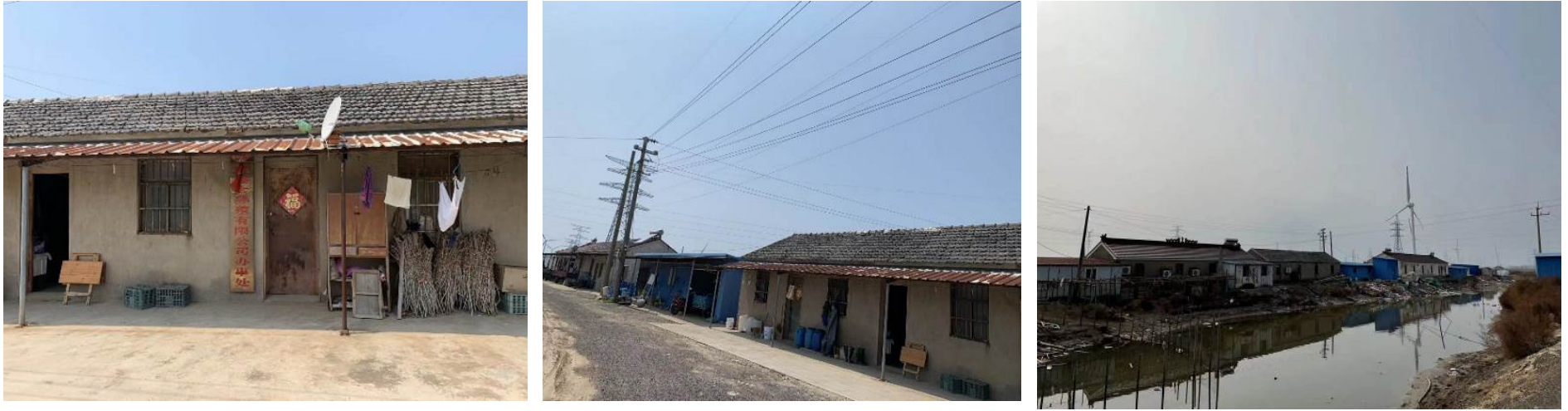
图 2.8-2(b) 架空线南侧 1 层尖顶房屋现状照片
