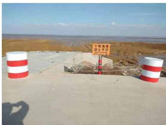
海缆登陆点电缆沟
