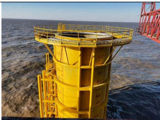
风机单桩基础防护
