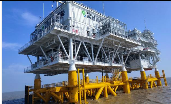
H5#-2 海上升压站
